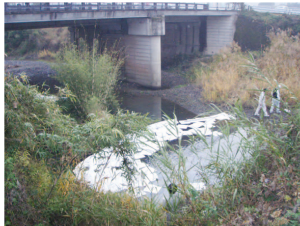
オイルフェンスの設置状況
