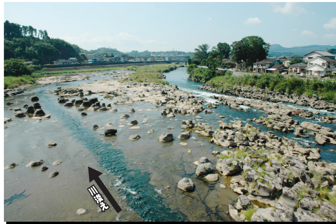
写真は川内川轟大橋下流部左岸側 轟之瀬
