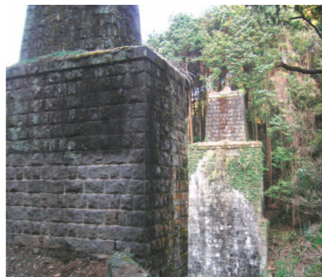
トロッコ列車の線路の橋脚
