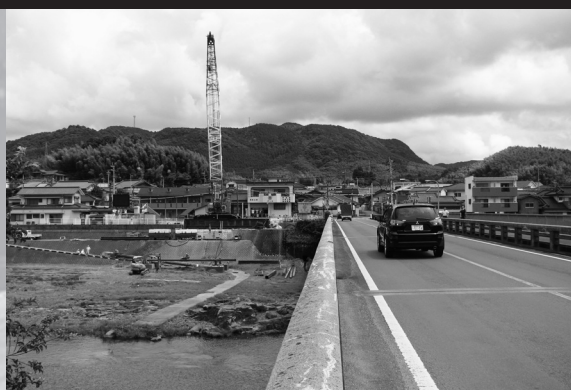
③宮都大橋架け替えに伴う仮橋工事
