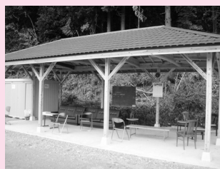
▼完成した、東屋
