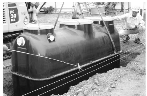
合併浄化槽を設置している様子
