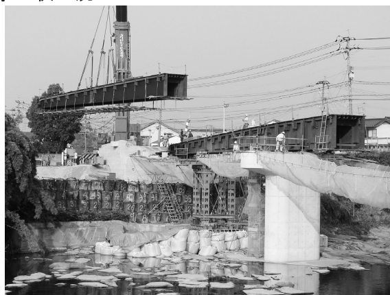
穴川橋工事状況
