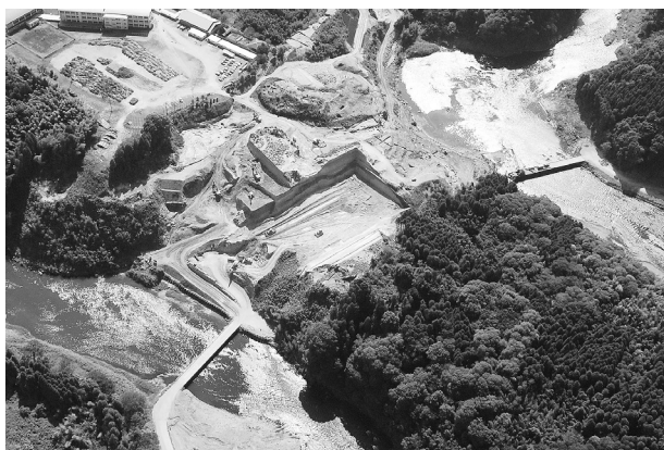
推込分水路 掘削状況
