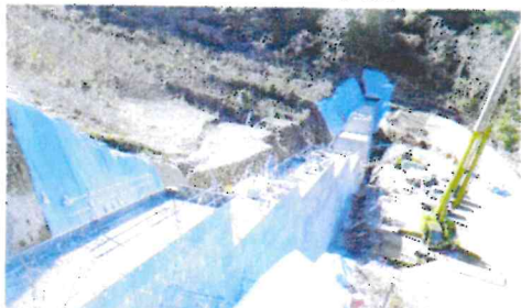
建設が進む旭地区観音平川流域の砂防ダム
