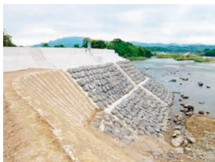
【竣工】 柏原第一樋門（柏原地区）
