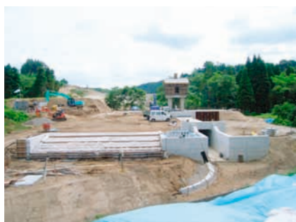
【施工中】 虎居樋門（虎居地区）
