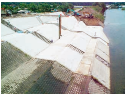
【施工中】 湯田第一樋門（湯田地区）
