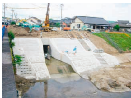
【施工中】 六川樋門（川原地区）
