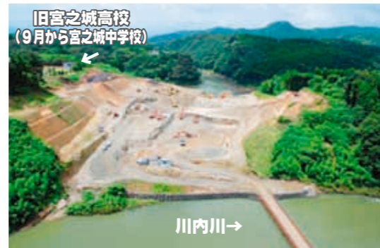
推込分水路航空写真 (虎居側より望む)
