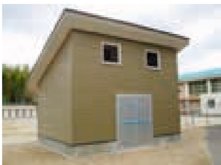
宮之城中学校敷地内に完成した倉庫
