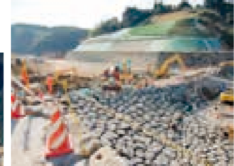
▲石張り施工状況写真
