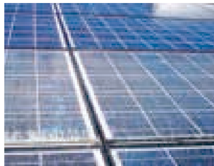
火山灰除去作業後(上段)と作業前(下段)
