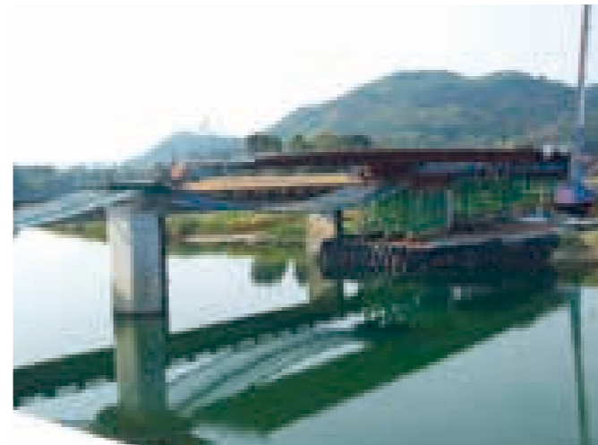
工事中の山崎橋
