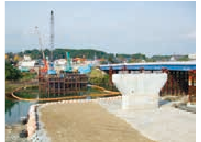
工事中の宮都大橋
