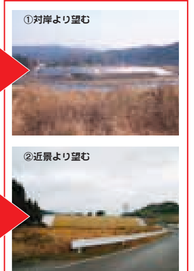
着工後(平成24年2月)
