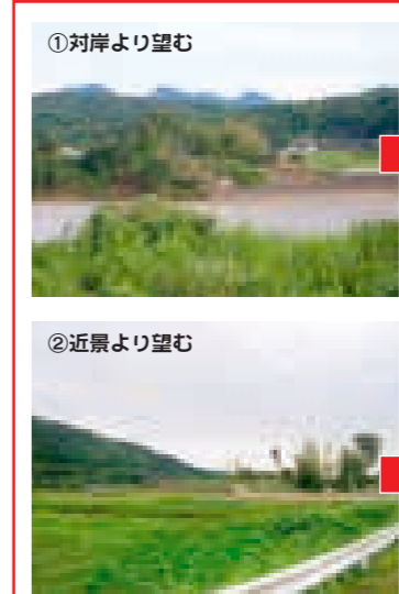
着工前(平成23年10月)
