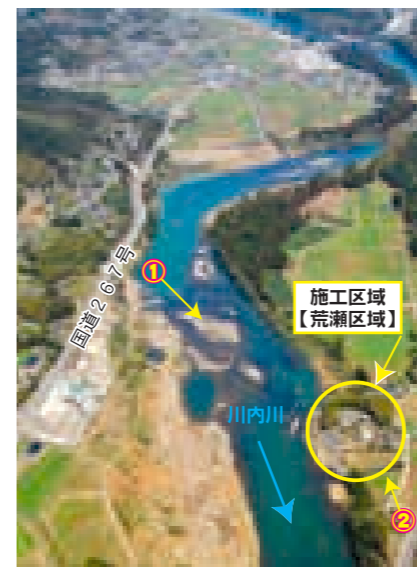
平成21年撮影(施工前航空写真)
