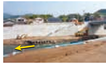
東橋下流右岸側
