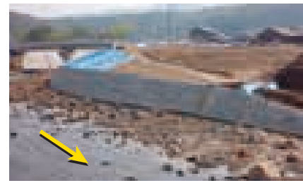
東橋下流左岸側
