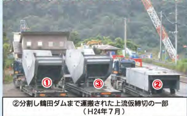
②分割し鶴田ダムまで運搬された上流仮締切の一部（H24年7月）
