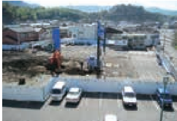
役場本庁舎屋上から撮影
