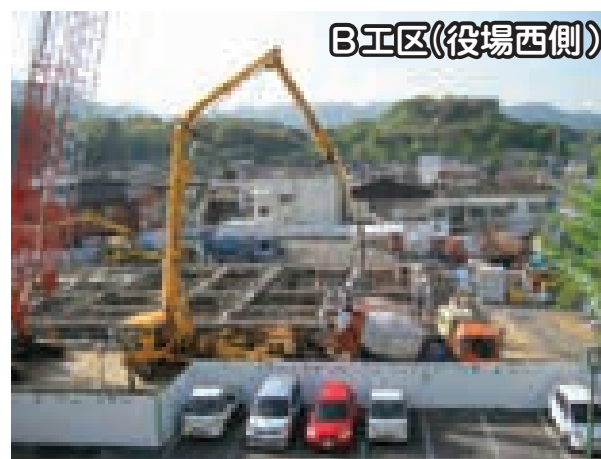
ポンプ車を使って基礎コンクリート打設が行われました。
