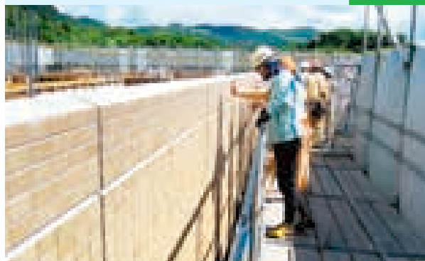
外壁を見ながら質問する部会員
