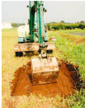
重機による表土剥き（向井原遺跡）
