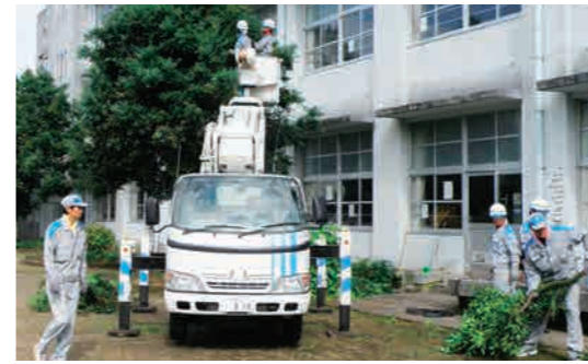
高所作業車での伐採作業
