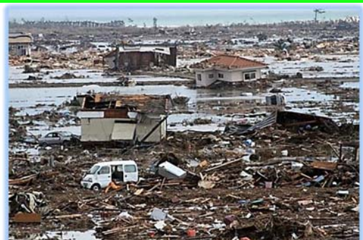
【東日本大震災による津波被害の様子】
