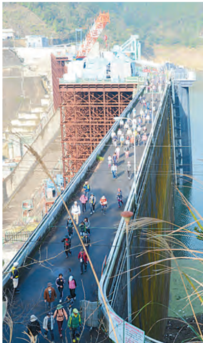
ダム工事を間近に眺めながらの散策
