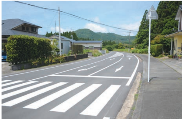
交付金を活用し舗装された町道五日町川口梁原線
