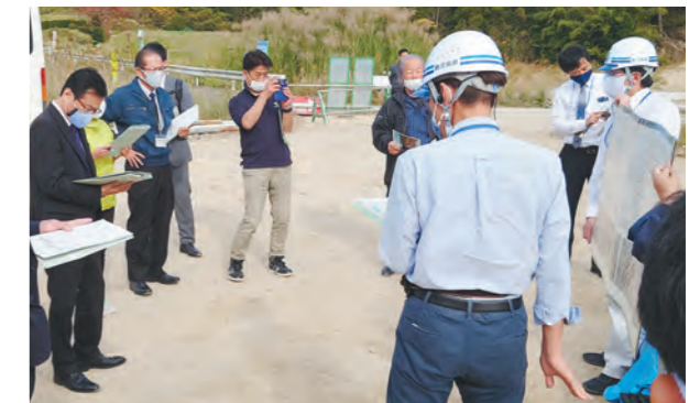
岩切副知事（左）に対し現地で工事概要や進捗状況を説明
