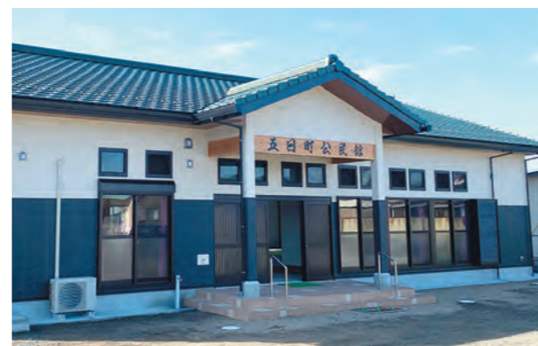
助成金を活用して建設した五日町公民館
