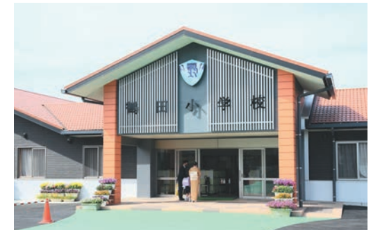
鶴田中学校跡地に新設された木造校舎
