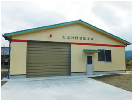
完成した佐志分団消防車庫
