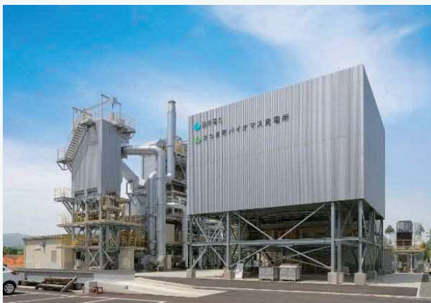
さつま町バイオマス発電所（自然電力）
