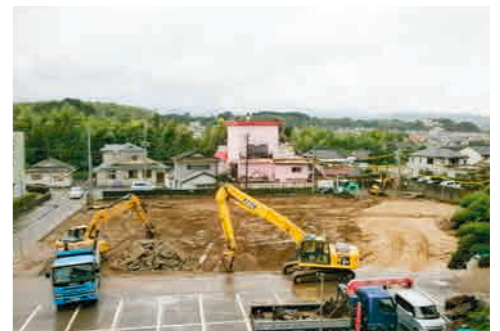
7月9日、整地作業が始まりました
