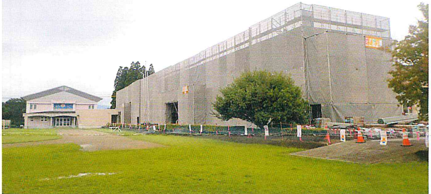
改修中の柏原小学校
