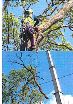
クレーンによる高所作業
