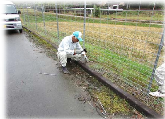
【鳥獣被害防止柵の設置】
